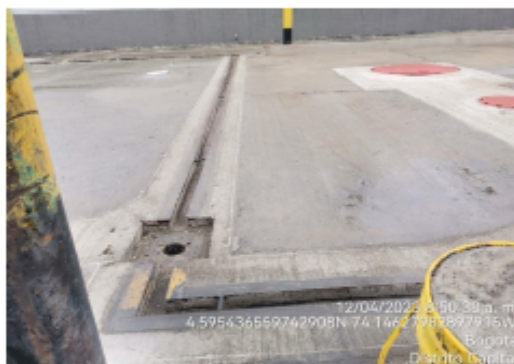
Fotografía No. 18 Canales perimetrales ubicados en el área de almacenamiento de combustible, costado suroccidental.
