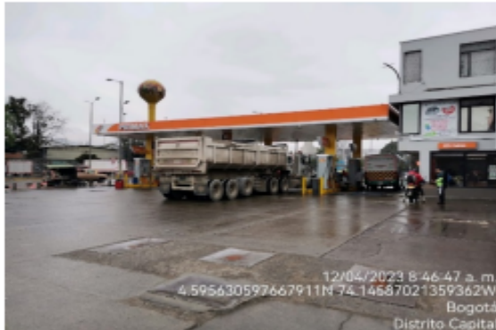
Fotografía No. 1 Estación de servicio ESSO DELICIAS.
