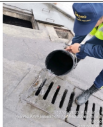
Fotografía No. 20 Prueba de agua realizada en la rejilla situada en el costado sur de la EDS.
