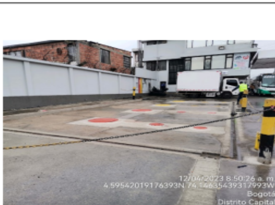
Fotografía No. 5 Canales perimetrales área de almacenamiento de combustible, ubicada en el costado suroccidental de la EDS.
