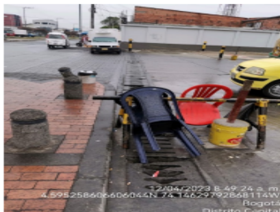
Fotografía No. 9 Rejilla perimetral ubicada en el costado sur de la estación.
