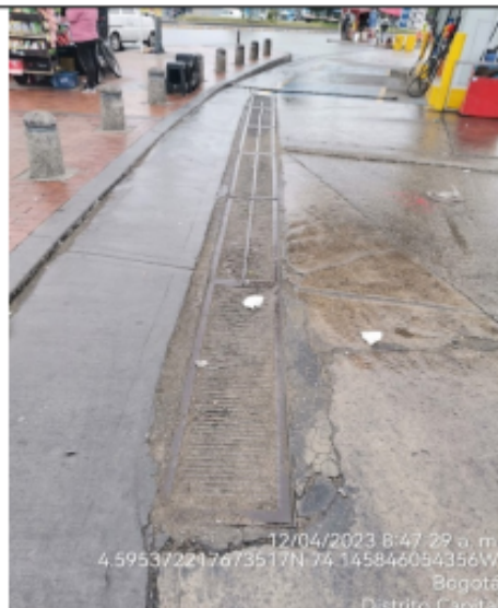
Fotografía No. 16 Rejilla perimetral ubicada en el costado nororiental de la EDS, la cual presuntamente está sellada.
