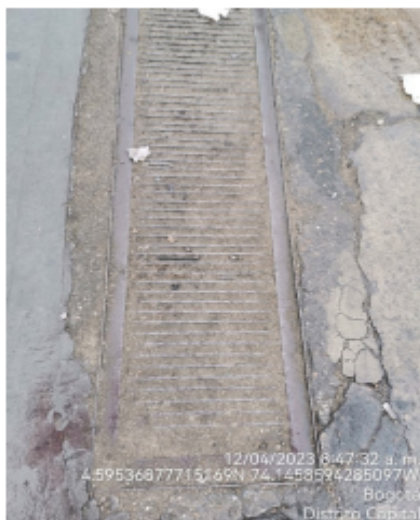
Fotografía No. 17 Rejilla perimetral ubicada en el costado nororiental de la EDS, la cual presuntamente está sellada.
