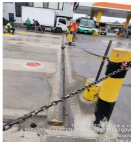
Fotografía No. 6 Canales perimetrales área de almacenamiento de combustible, ubicada en el costado suroccidental de la EDS.
