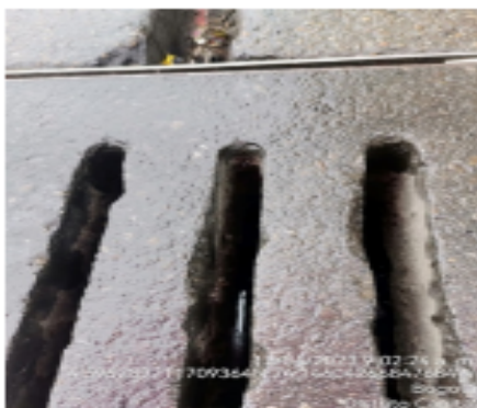
Fotografía No. 27 Se evidenció la descarga del agua lluvia de la red del canopy a la rejilla perimetral ubicada en el costado suroriental, sector salida de la EDS.
